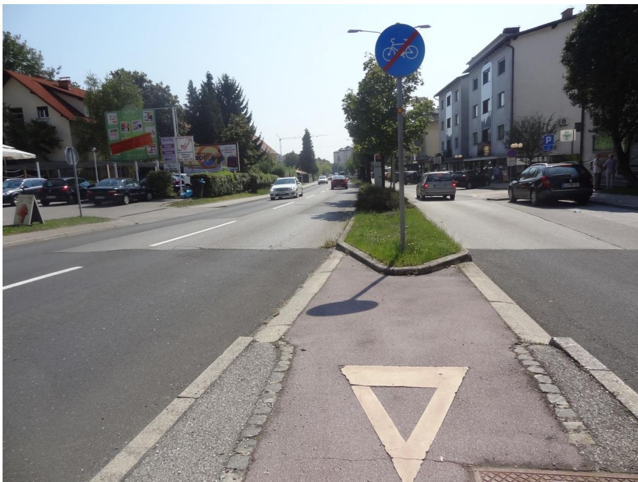
Nevarno vključevanje kolesarjev na cesto
